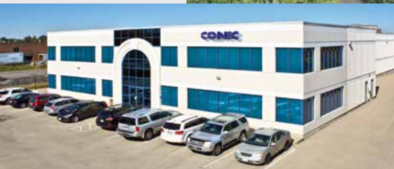
CONEC Canada, Brampton
